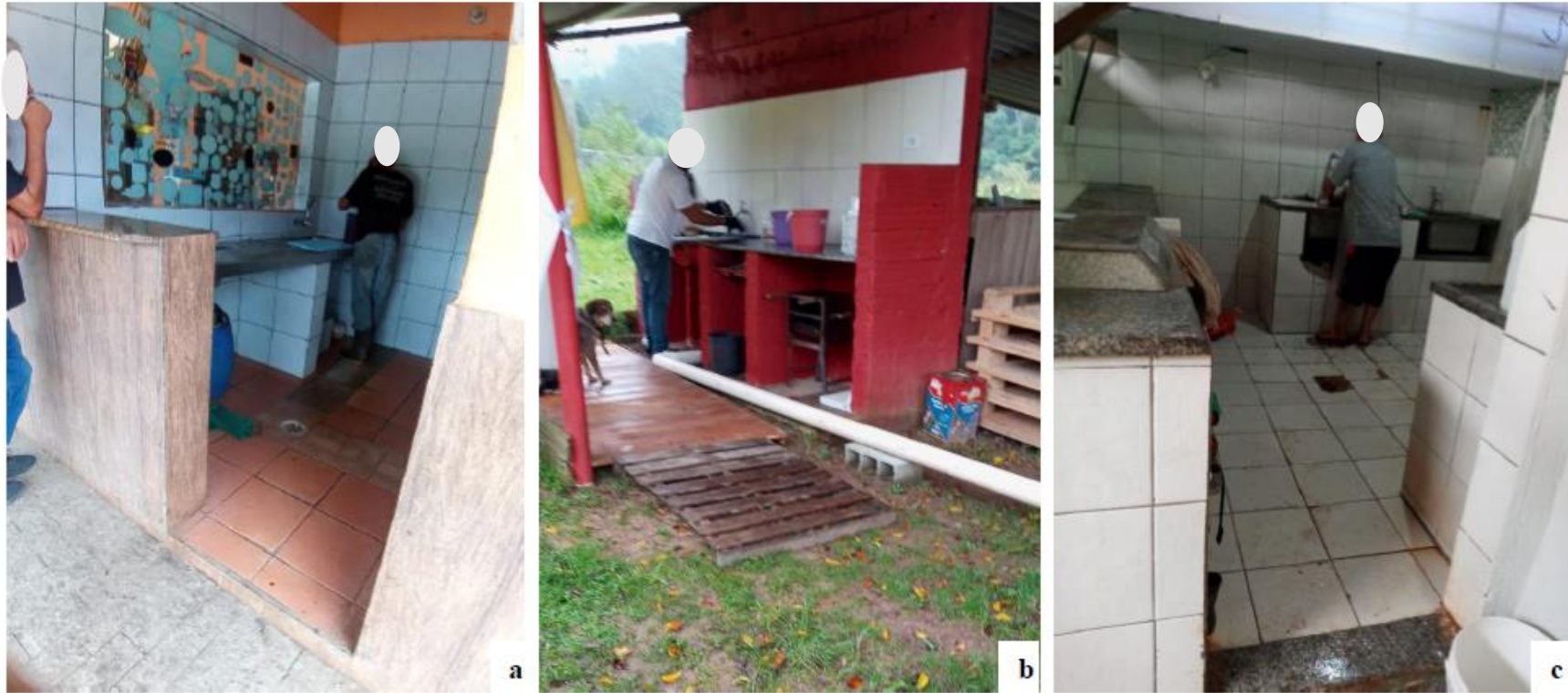
Figura 24 – Ausência de barreiras físicas contra a entrada de pragas nas áreas de filetagem dos pesqueiros: a) Pesqueiro PF5 – ausência de porta com tela milimétrica e abertura da meia parede no canto esquerdo da foto; b) Pesqueiro PF16 - área de filetagem totalmente aberta, sem barreiras físicas contra a entrada de pragas; c) Pesqueiro PF9 – ralo na área de filetagem aberto, permitindo o acesso de pragas.
