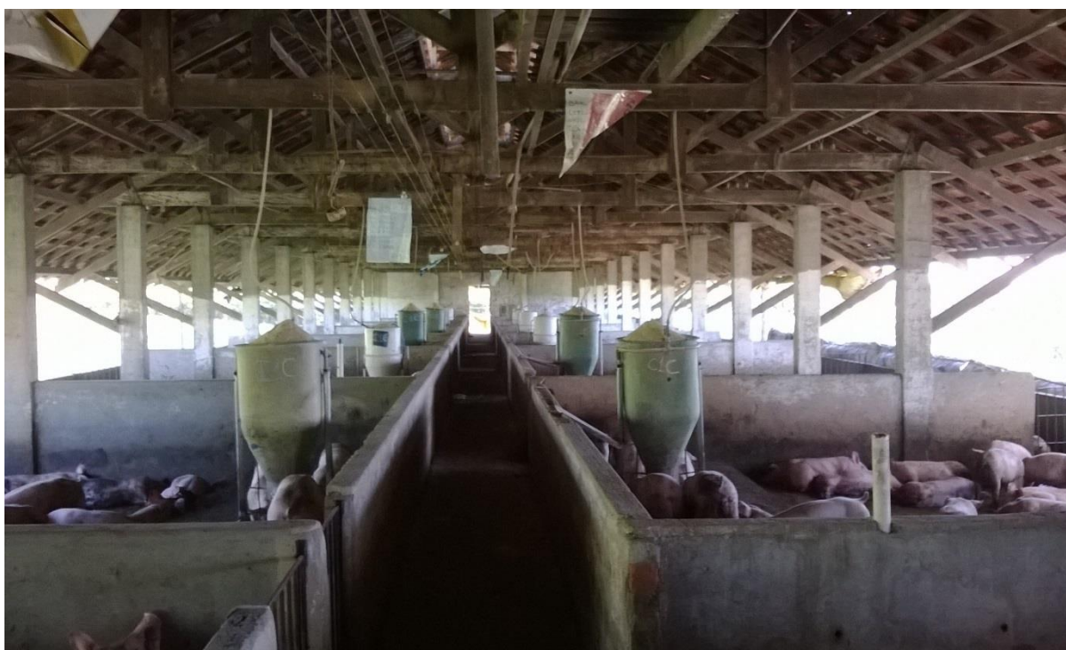
Figura 4 - Estrutura interna do galpão de terminação (Granja 1).
