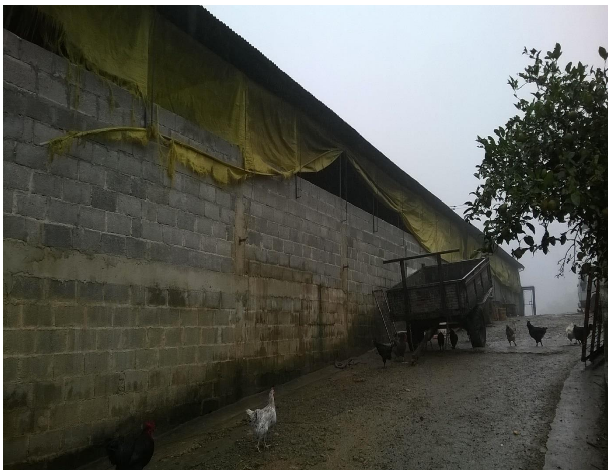
Figura 12 - Parte externa do galpão de terminação e maternidade de suínos com presença de aves no local (Granja 3).
