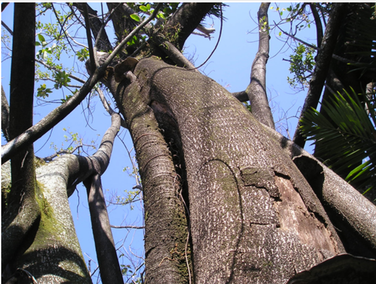
Fig. 3 - Tronco principal de Ficus elastica apresentando rachaduras na casca.
